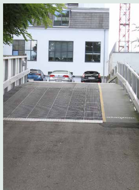
Skridsikker passage fra parkeringspladsen til kontorbygningen.
