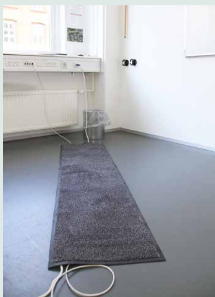
Arbejdstilsynet anvender tæpper til at forebygge risikoen for at snuble over ledninger, der må trækkes over gulve i mødelokaler.
